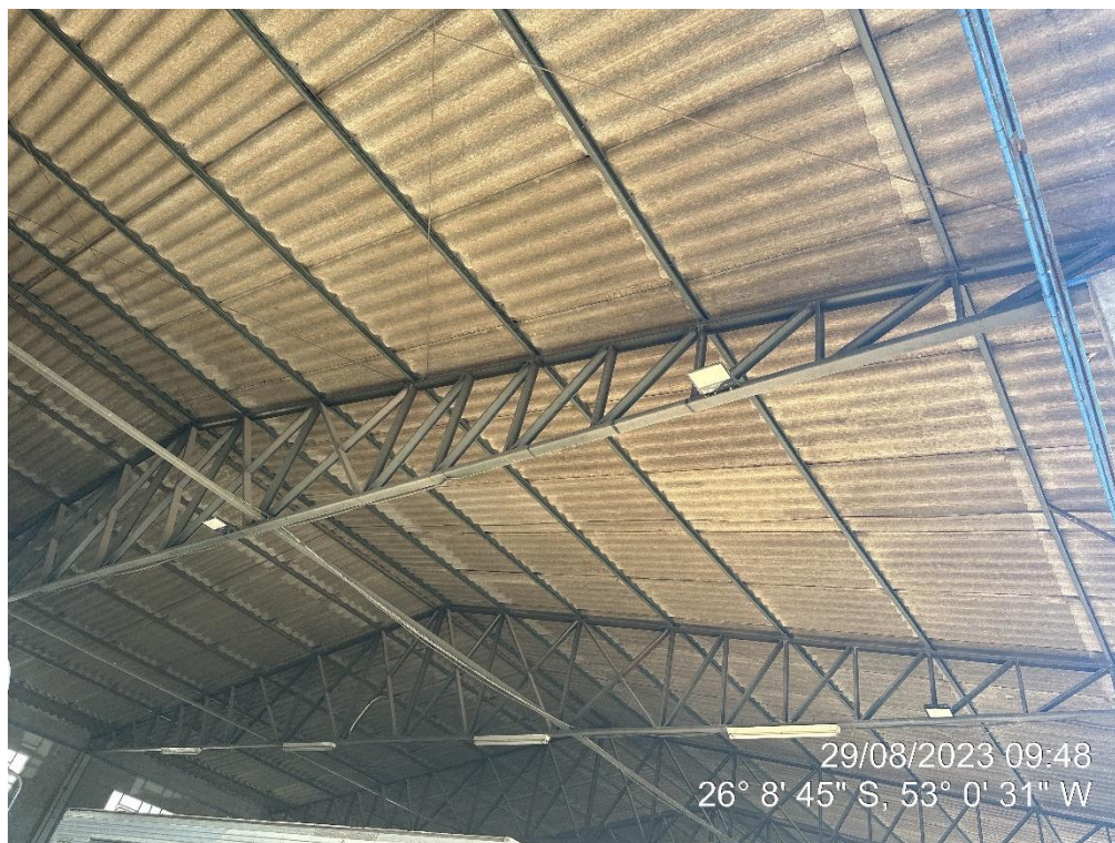
Figura 3 – Vista barracão: parte interna do telhado.
