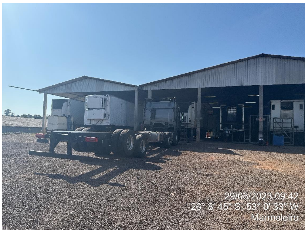
Figura 2 – Vista telheiro: frente para Rua Paraná.
