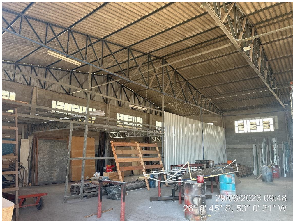
Figura 9 – Vista interna do barracão.
