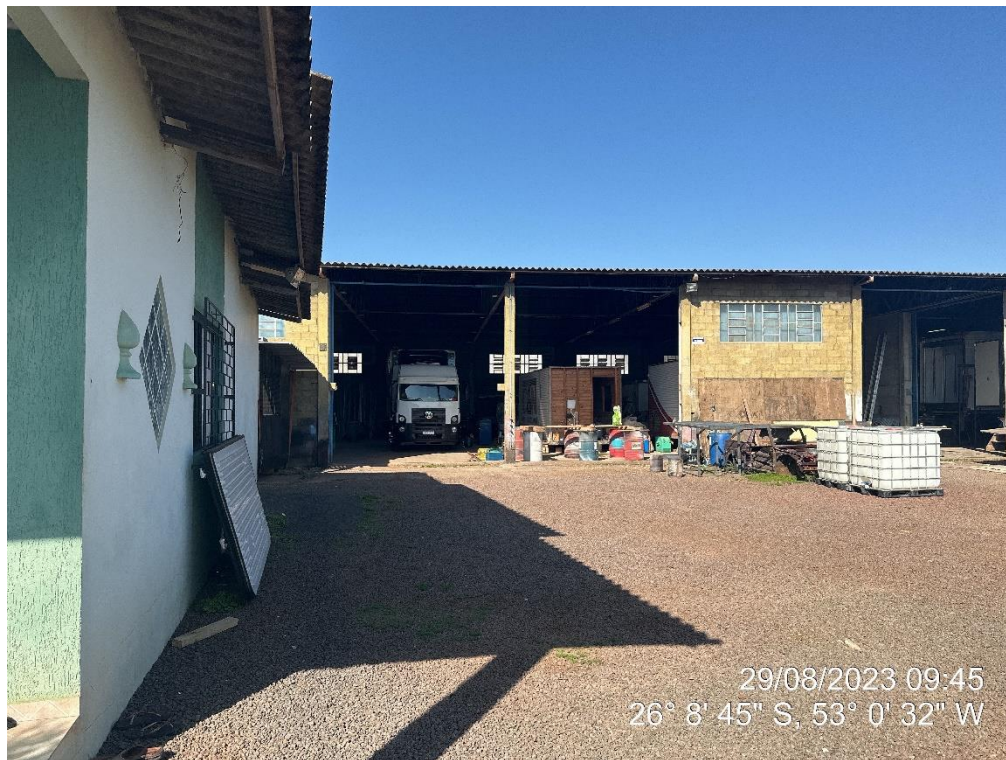
Figura 7 – Vista barracão: lateral.
