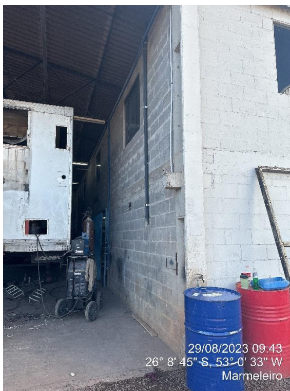
Figura 10 – Vista interna do barracão.
