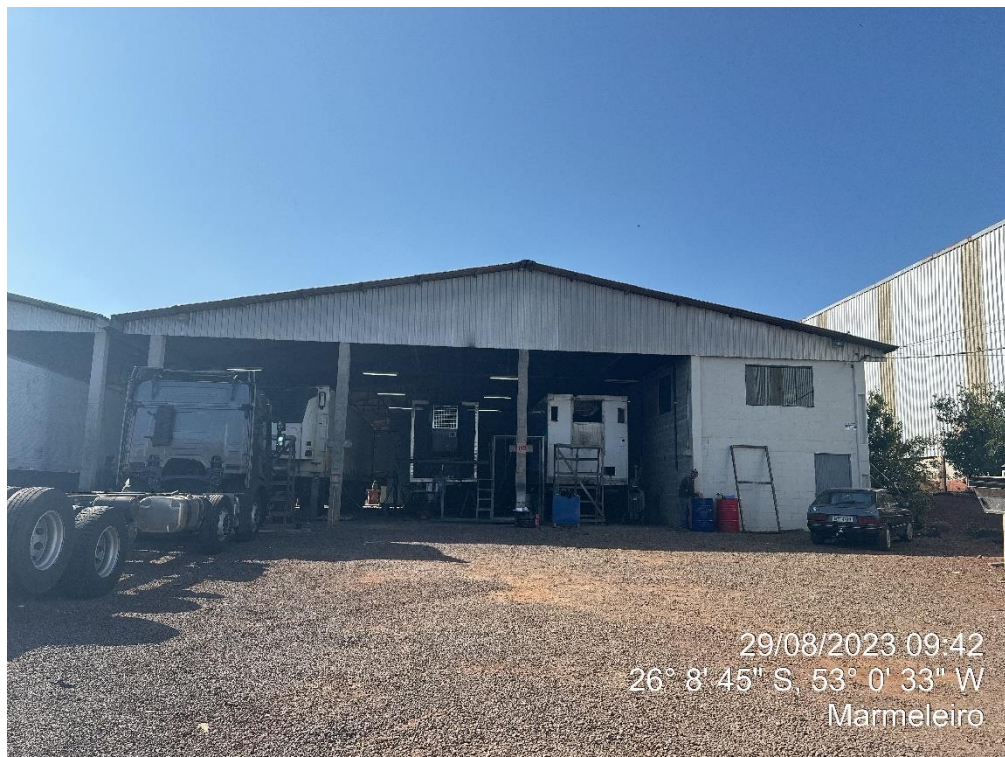
Figura 1 – Vista barracão: frente para Rua Paraná.
