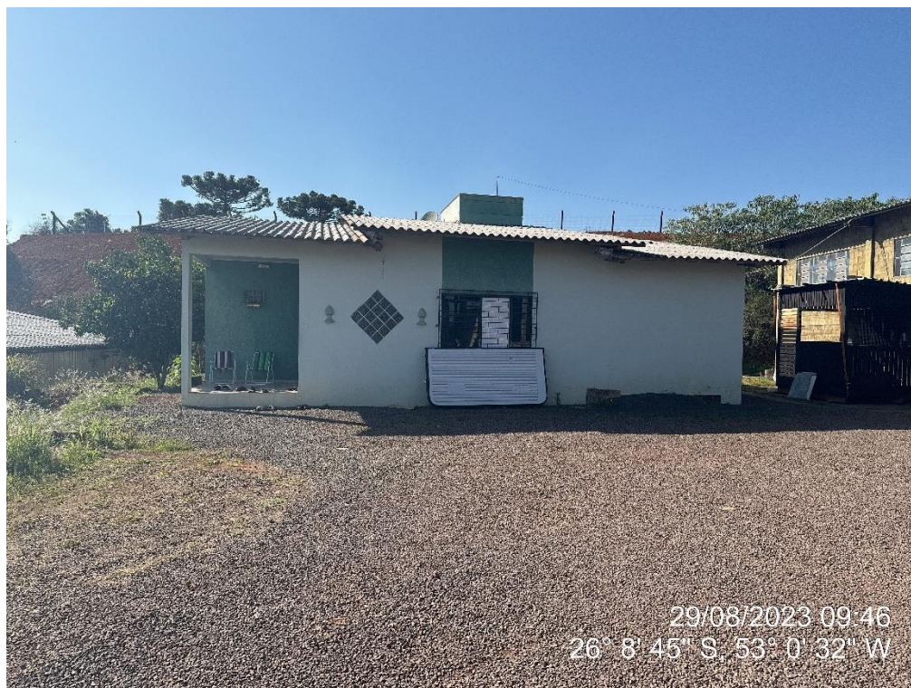
Figura 6 – Vista residência: frente.
