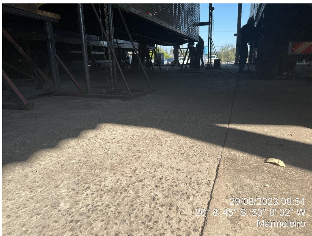
Figura 4 – Vista barracão: revestimento piso.
